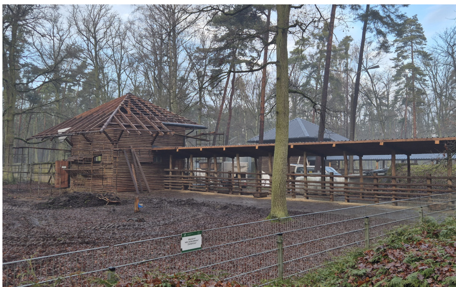
Ryc. 2. Remont dachów na budynkach gospodarczych w Pokazowej Zagrodzie Zwierząt, grudzień 2025 (fot. T. Rakowski) Fig. 2. Roof repairs on administrative buildings at the Model Animal Pen, December 2025 (photo by T. Rakowski)
