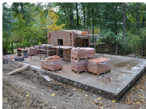
Etapy rekonstrukcji chałupy: wykonanie fundamentu i komina... (fot. R. Sorek)
