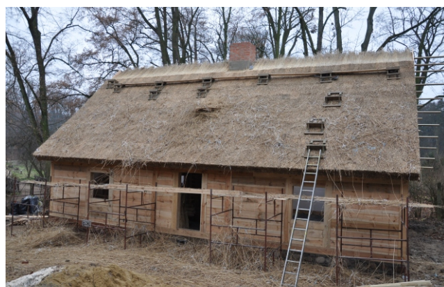
Krycie dachu strzechą (fot. R. Sorek)
