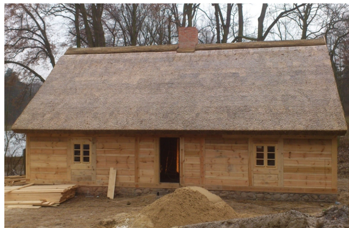
Główne prace nad elewacją zewnętrzną dziewiętnastowiecznej chaty zostały zakończone na początku grudnia 2012 r. (fot. R. Sorek)
