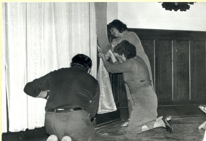
Ostatnie prace remontowe i porządkowe przed otwarciem „Oficyny”, wrzesień 1986 r. (fot. K. Bul)
