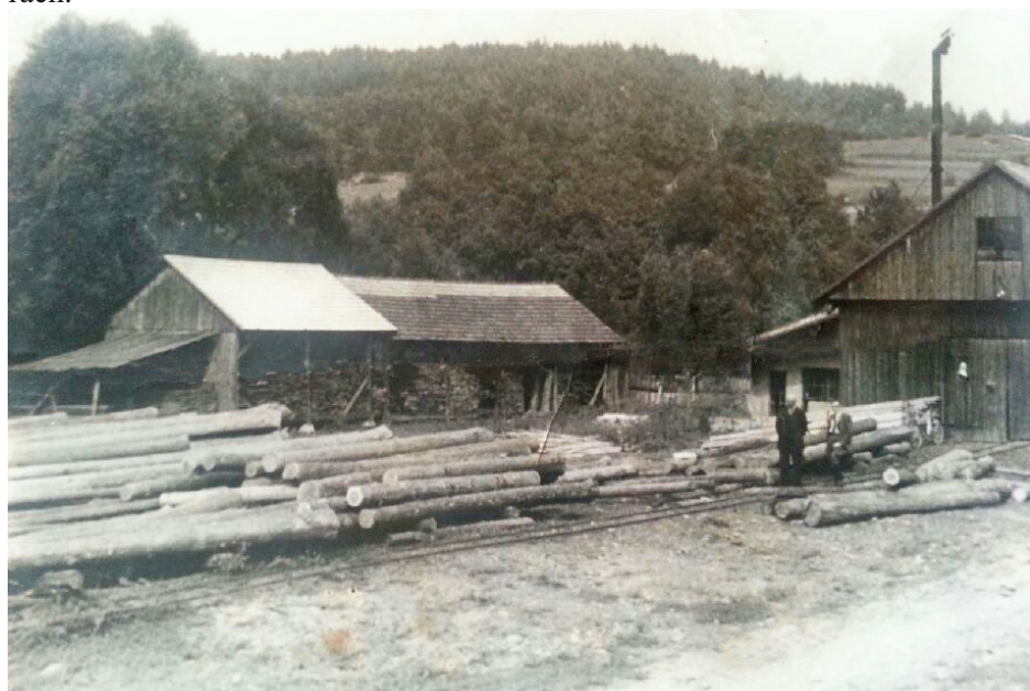
Tartak przed powodzią w 1934 r.; nad dachem hali tartacznej komin lokomobili, z przodu skład surowca, w głębi skład tarcicy (fot. Arch. rodzinne)
