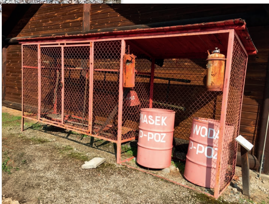
Stojak na sprzęty przeciwpożarowe (fot. I. Belińska)
